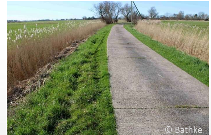
Betonplattenweg in Butjadingen, Breite: 2,5 m
