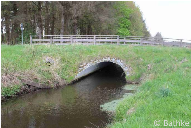
Erneuerter Brückendurchlass Stadt Geestland
