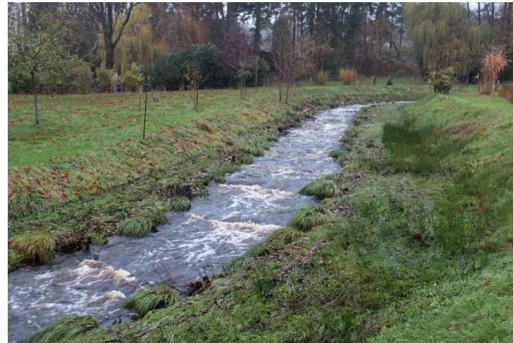
Nach Umbau: mäandrierendes Raugerinne mit Beckenstruktur
