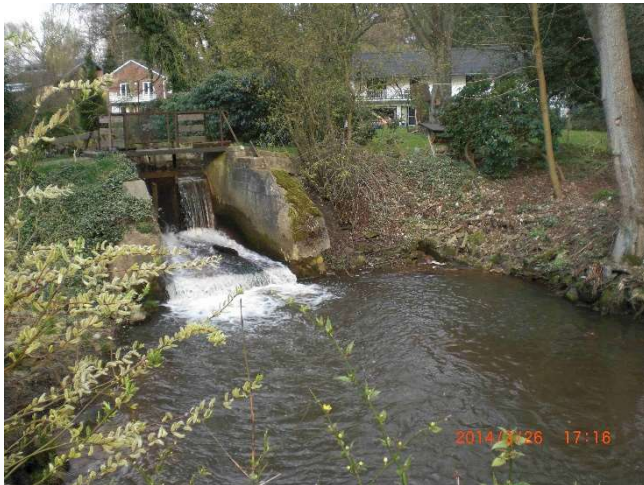
Ehemaliges Staubauwerk, 1,7 m Höhe
