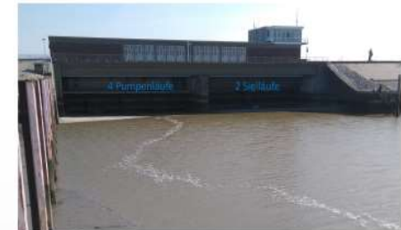
Siel- und Schöpfwerk Knock, Foto: O.-D. Finch, NLWKN
