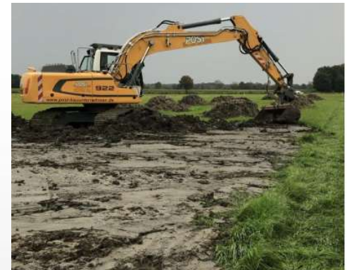
Verteilung von Baggergut mit dem Kettenbagger, Foto: LWK Nds. 2021
